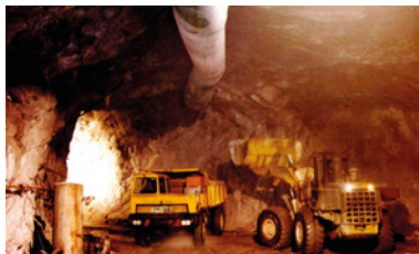
PROGETTO IDROELETTRICO E GALLERIA DI DERIVAZIONE "EDOLO" ITALIA
